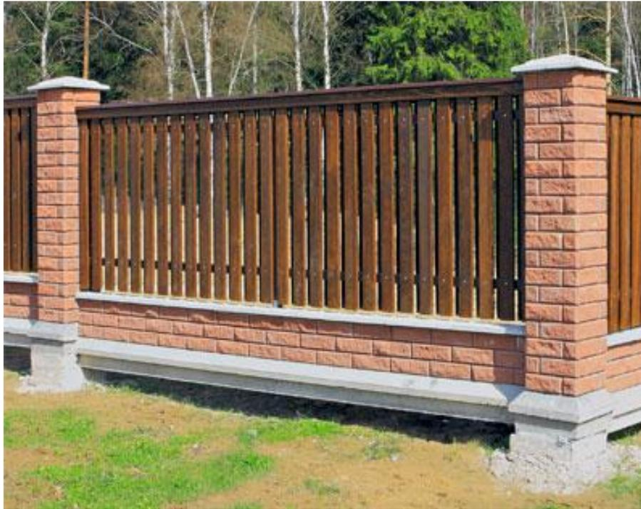
При строительстве заборов из элементов Brick, в большинстве случаев, используются столбчатые фундаменты. Применение ленточных фундаментов возможно и объяснимо в следующих случаях:
